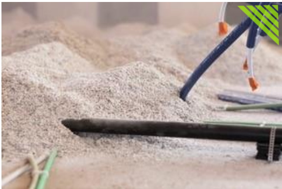
Figuur 2: kalkhennep vloerisolatie kantoor D'hulst door Eltherm. © EXIE
