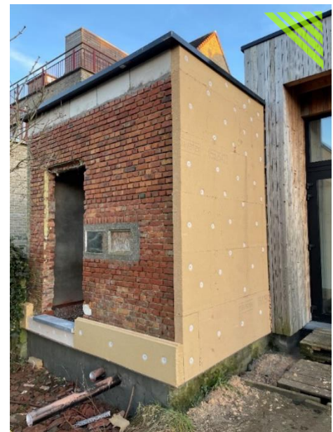
Figuur 3: Energetische renovatie met houtvezelplaten © Ecoverbo
